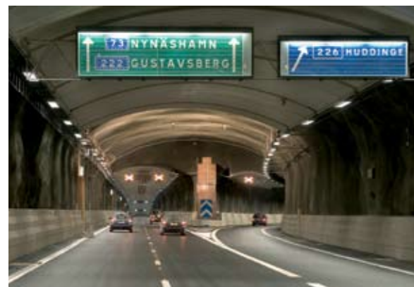
Οι λαμπτήρες Long Life χρησιμοποιήθηκαν για να εγγυηθούν φωτεινότητα ακόμα και σε χαμηλές θερμοκρασίες, στη μεγαλύτερη οδική σήραγγα της Σουηδίας, τη Södra Länken.
