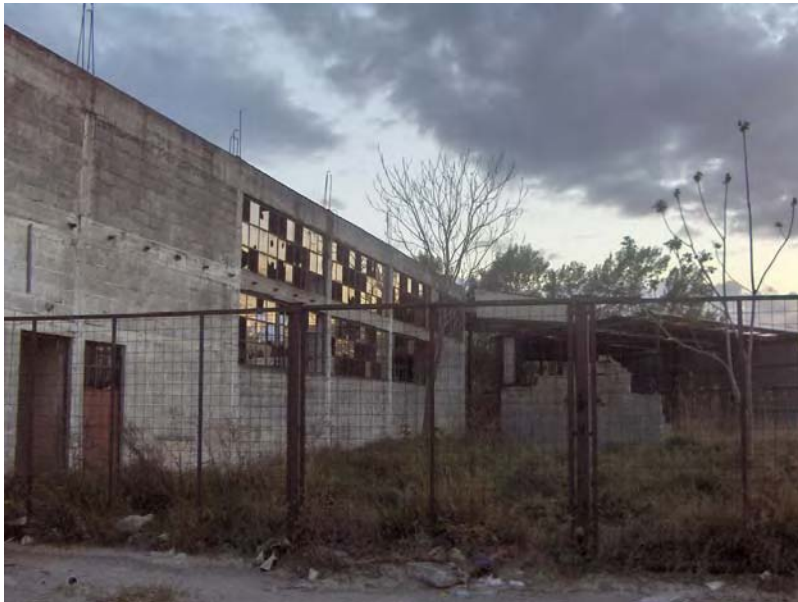
Εικόνα 285. Όψη στον ακάλυπτο χώρο του οικοπέδου, απ' όπου γίνεται η είσοδος στο κτίριο
