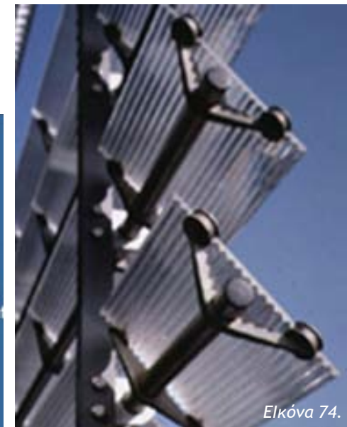
Εικόνα 74. εφαρμογή πρισματικού τζαμιού σε εξωτερικές περιόδους - πηγή: cres
