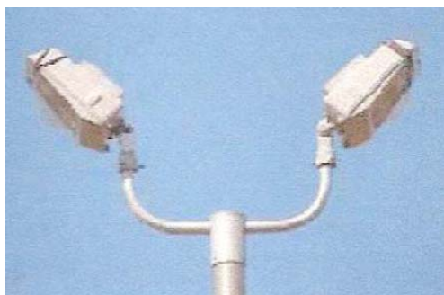
Σχήμα 3-6: Φωτιστικό σώμα κατακόρυφης διάταξης
