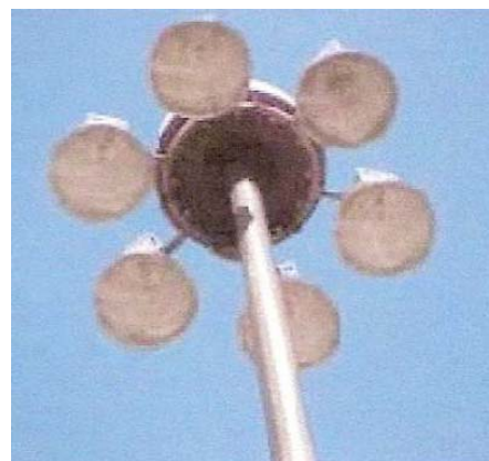
Σχήμα 3-7: Φωτιστικό σώμα υψηλού ιστού
